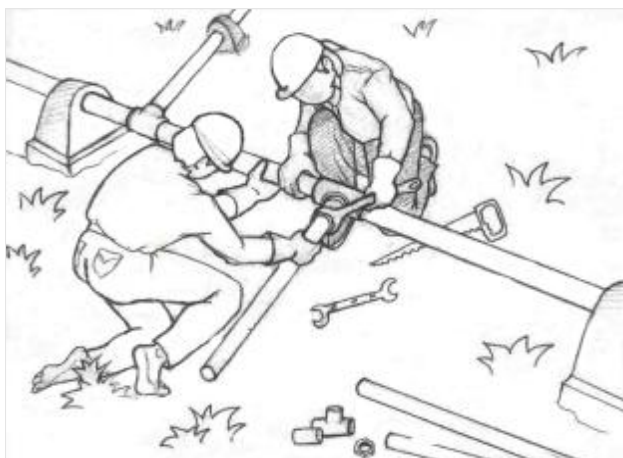
Hình 20: Bảo d-ỡng đ-ờng ống, vận chặt những chỗ bị rò rỉ.
