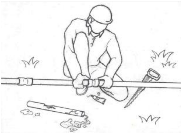
Hình 26: Nối ống PVC khi có phụ kiện.
