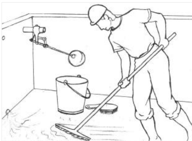
Hình 18: Cọ rửa bể chứa n- ớc sạch.
