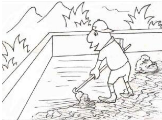
Hình 15: Nạo vét bùn đất, bảo dưỡng bể lọc.
