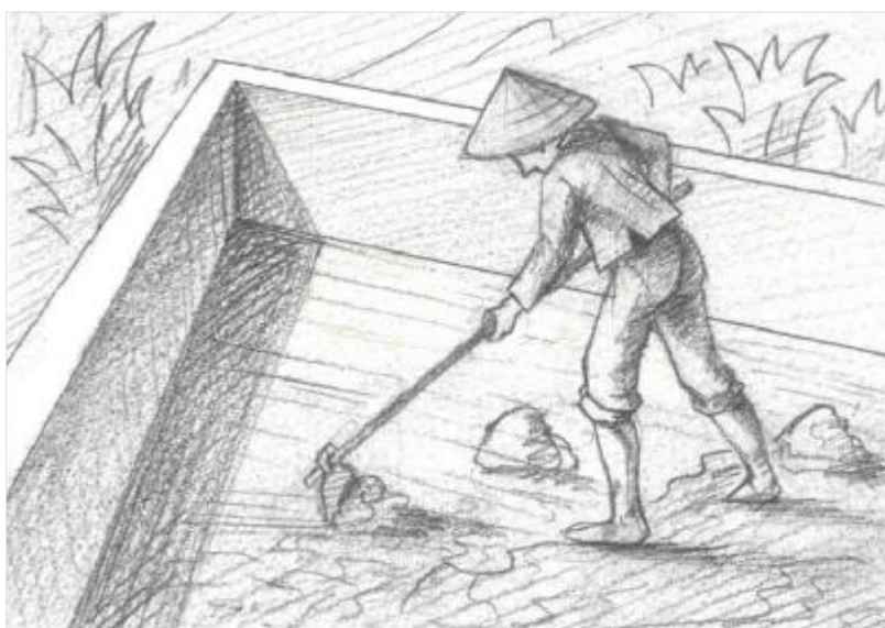
Hình 7: Kiểm tra thau rửa bể lọc chậm
